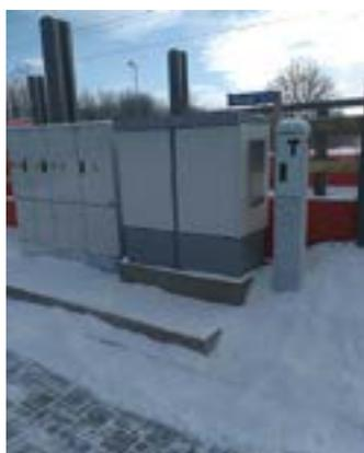
Las condiciones de intemperie pueden ser muy agresivas para los equipos alojados en los armarios eléctricos, por lo que las unidades de refrigeración deben soportar estas condiciones con un grado de IP adecuado y capacidad para trabajar en entornos de temperaturas extremas tanto de frío como de calor intenso.
