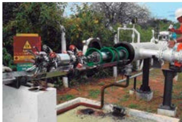
Figura 2. EngeMOVI está lanzando su primera prueba de campo en una tubería.
