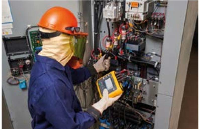
Los registradores de calidad eléctrica como el Fluke 1736 pueden identificar problemas intermitentes y recoger información para calcular el pico de demanda y el factor de potencia.
