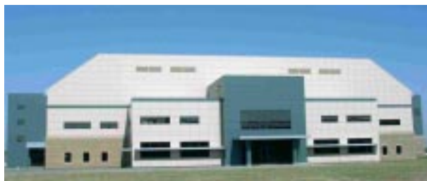
Figura 1. Centro de Producción de chips E-pHEMT de Agilent Technologies, Ft. Collins, Colorado
