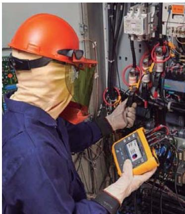
ver si hay algún componente suelto o si se ha producido sobrecalentamiento. En esta etapa puede ser útil contar con una cámara termográfica para localizar rápidamente conexiones o disyuntores sobrecalentados. También es un buen momento para prestar atención a los valores de los disyuntores.
