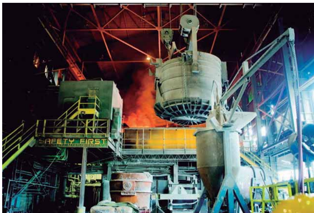
Figura 2. Nucor Steel actualizó su acería de Marion en Ohio con un sistema basado en la plataforma NI CompactRIO, que es lo suficientemente flexible como para monitorizar la calidad de energía y proporcionar información para controlar el proceso de fusión de la chatarra de acero, reduciendo al mínimo las multas de los servicios públicos.
