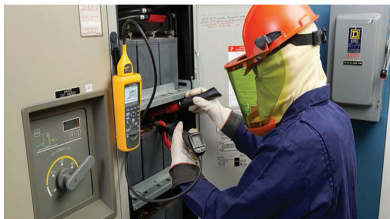
Figura 2. Uso del analizador Fluke BT52X para medir trimestralmente el valor óhmico de la impedancia de la celda/batería.
