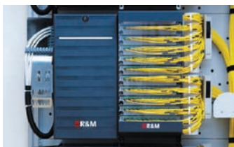
El módulo combinado reúne las secciones de empalme y parcheo en una sola carcasa y está igualmente disponible como unidad pre terminada y probada en fábrica.
