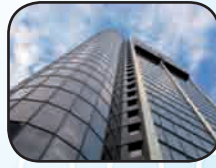
Automatización de Edificios
