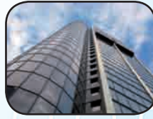
Automatización de Edificios
