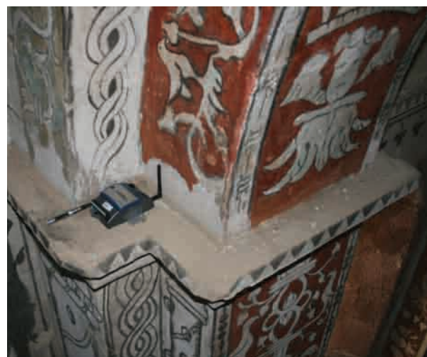
Figura 3. Nodos WSN-3202 sin caja protectora
