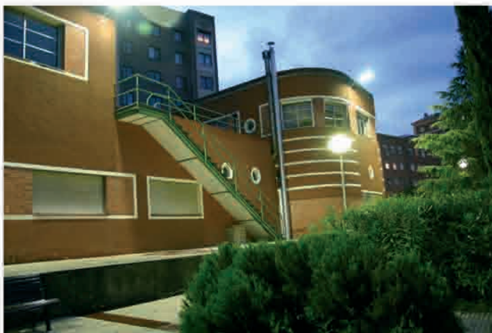
iluminación LED civil
