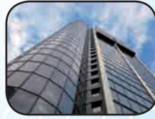
Automatización de Edificios
