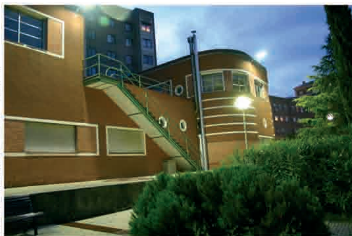
iluminación LED civil
