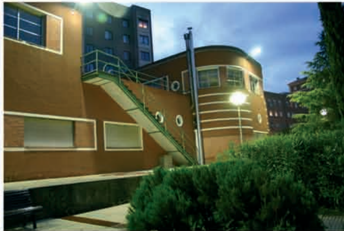
iluminación LED civil
