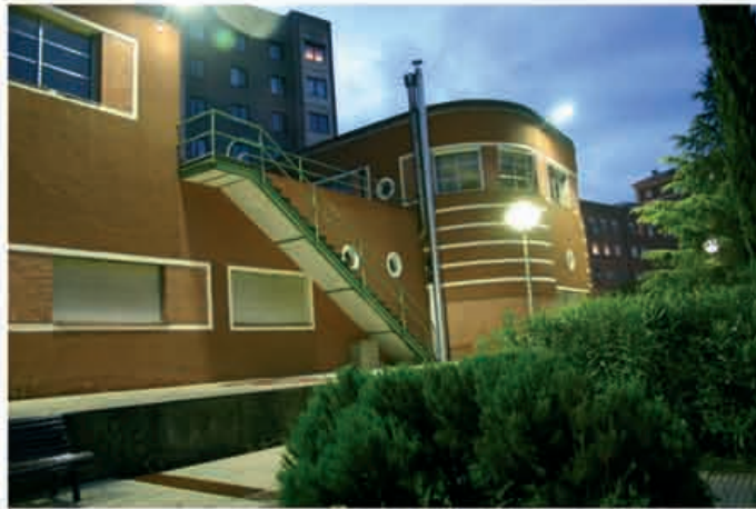
iluminación LED civil
